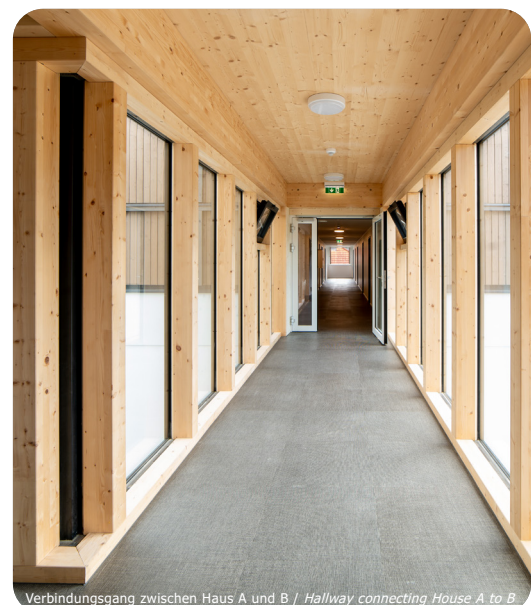
Verbindungsang zwischen Haus A und B / Hallway connecting House A to B
