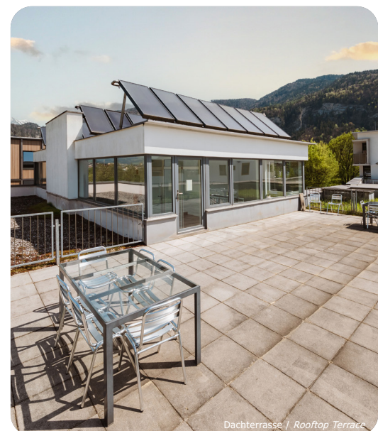
Dachterrasse / Rooftop Terrace
