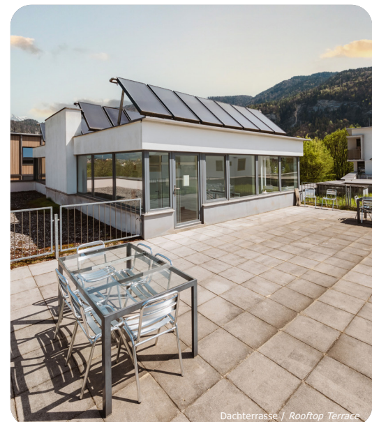
Dachterrasse / Rooftop Terrace
