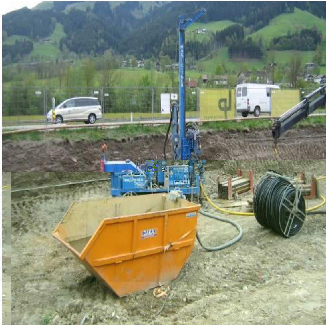
Installation einer Erdsonde in das Bohrloch
