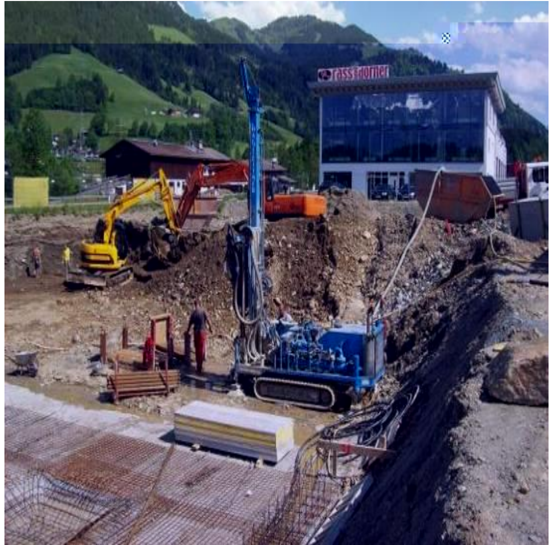
Bohrung der 2.800 m Erdwärmesonden
