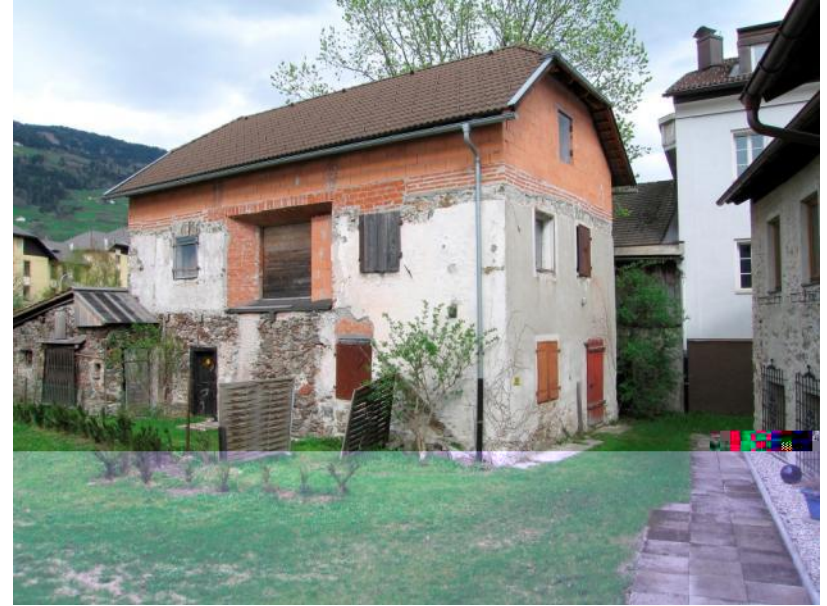
Bestand vor Sanierung
